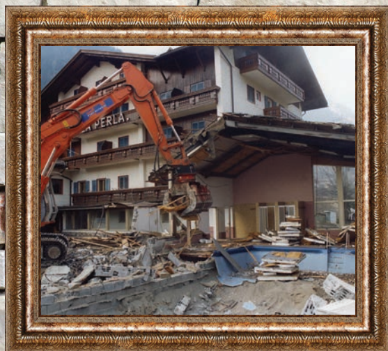
2001: iniziano i lavori di ampliamento
