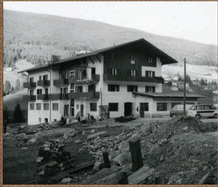
Das Hotel La Perla während der Bauarbeiten im Jahr 1963
